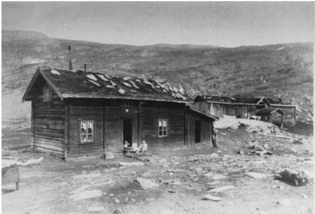
Reinhagen fotografert i 1914. Da Olea Sørensen solgte huset til gruveselskapet i 1911 hadde huset denne formen. Takhøyden i 1.etg var 2,1m. og hadde to værelser, kjøkken og gang. I 2.etg. er ett rom
